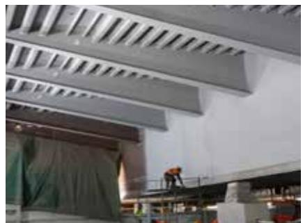
Zingaceram PU is een twee componenten acrylaat polyurethaanverf. Zingaceram PU biedt een uitstekende hechting en is beschikbaar in de meeste RAL kleuren. Door de keramische partikels (anorganische, niet-metallische materialen), biedt het een uitzonderlijke barrière tegen de omgeving met als resultaat een hoge chemische en abrasieve weerstand. Zingaceram PU wordt aangeraden als gekleurde eindlaag in een ZINGA systeem.
